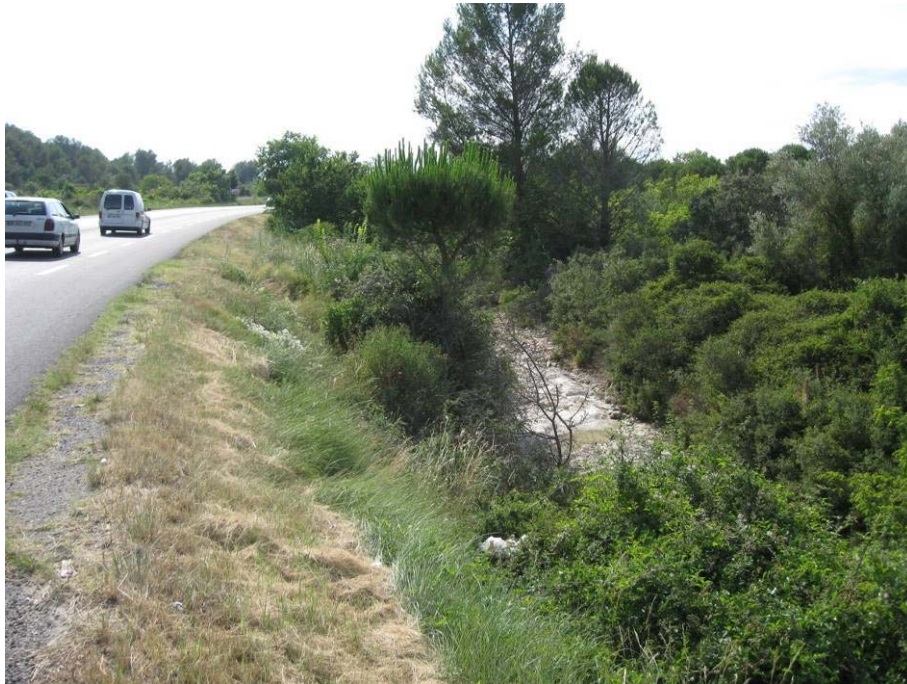
Figure 1 : Remblai routier longé par le Rianse.
