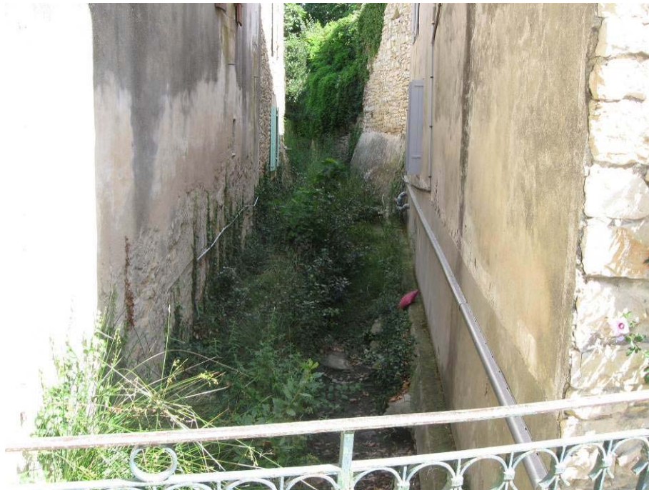
Figure 4 : Endiguement par des murs d'habitations dans la traversée de Saint-Côme
